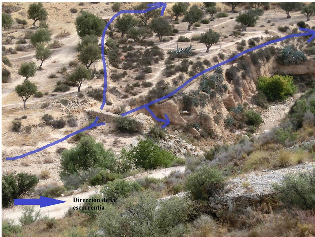
Por último, a unos 3 Km., aguas abajo en las Casas del Barranquet se encuentra la “Boquera del Barranquet”. El agua era desviada desde la misma rambla, que es utilizada como cañada, a través de un dique de derivación que estaba compuesto por tablachos (aún quedan restos de los partidores) hacia los campos de cultivo que se encuentran contiguos al barranco ocupando una superficie aproximada de 8,99 ha. (tabla 4).
