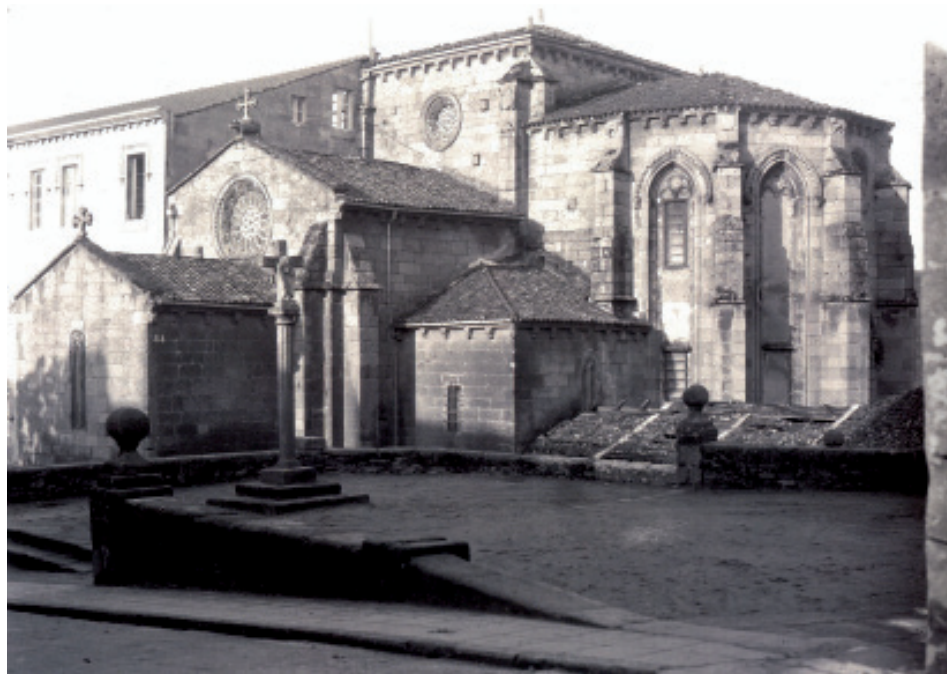
1. Fotografía del convento en 1926 donde se observa cómo se alinearon los aleros del edificio nuevo con la cubierta del crucero (ANDERSON, Ruth Matilda, 2009, Una mirada de antaño. Ed.: Fundación Caixa Galicia. A Coruña, p.122).
