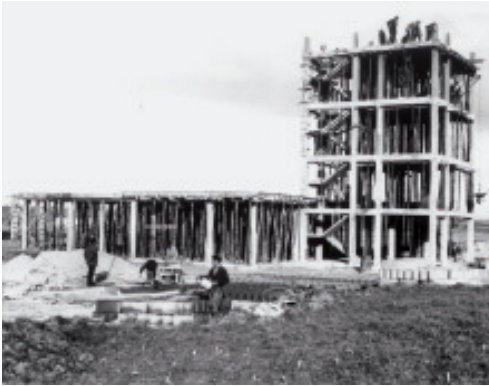
Construcción del Edificio Terminal. Abril 1962. Foto Archivo Alberto Martí Villardefrancos.
