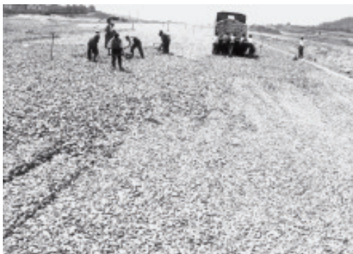
Trabajos de explanación de la pista Foto Archivo Alberto Martí Villardefrancos.
