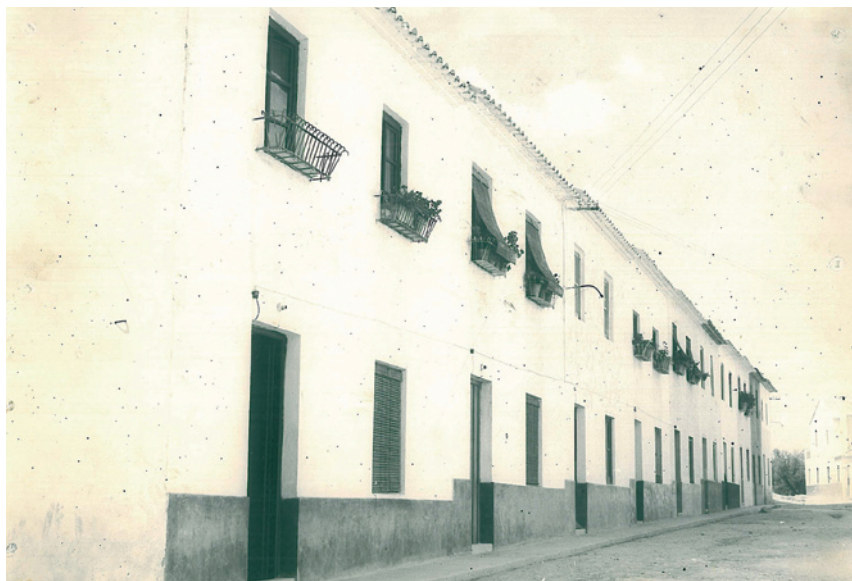
Viviendas tipo Belén, en Cárcheles, construidas en la década de los años cincuenta Fuente: Ayuntamiento de Cárcheles
