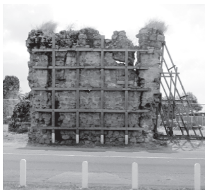
Figura 20. El Convento de San José antes de la intervención. (Foto: Patronato Panamá Viejo)
