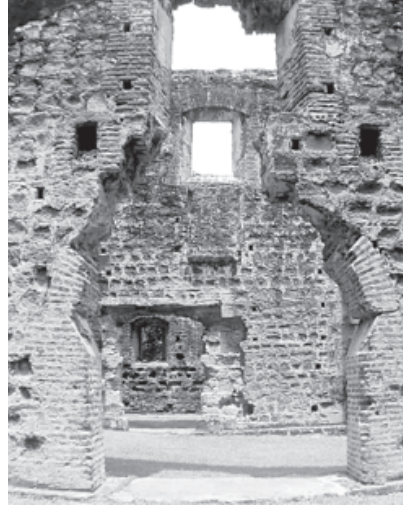
Figura 12. Vano o abertura de la capilla Norte antes de la reintegración. (Foto: Patronato Panamá Viejo)
