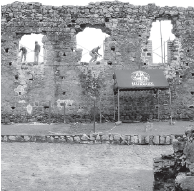
Figura 8. Vista del muro oeste de la Catedral antes de su intervención. (Foto: Patronato Panamá Viejo)
