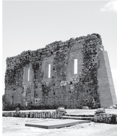
Figura 9. Imagen del muro oeste de la Catedral después de su intervención. (Foto: Patronato Panamá Viejo)
