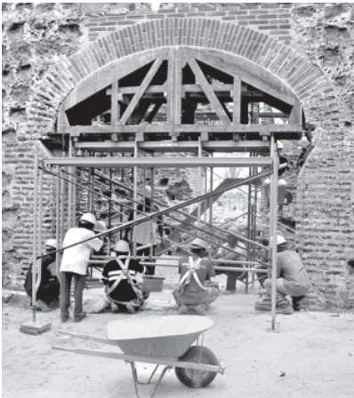
Figura 13. Para realizar este trabajo fue necesaria la construcción de una cimbra. (Foto: Patronato Panamá Viejo)
