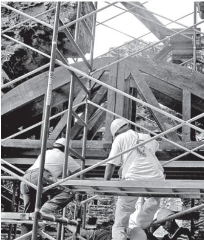
Figura 15. El montaje del arco comenzó por la colocación de sus dovelas, y su construcción duró dos semanas. (Foto: Patronato Panamá Viejo)
