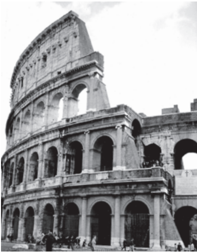
Figura 1. Imagen del contrafuerte del Coliseo Romano construido por Raffaele Stern en 1807. (Foto de la autora)
