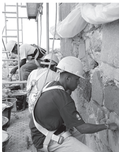
Figura 5. Detalle de los trabajos de conservación realizados en los muros de la Catedral. (Foto: Patsy Rodríguez)
