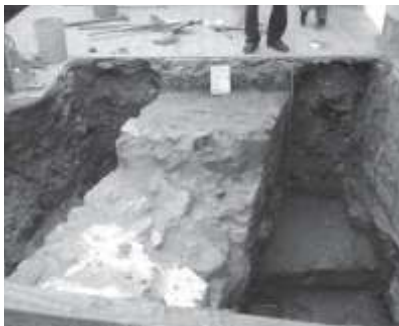
Figura 3. Vista del lienzo de muralla en la CDR desde el oeste. Al extremo derecho está la fundación de cemento para la fachada del inmueble actual. Nótese la mampostería ordinaria al centro de la estructura.
