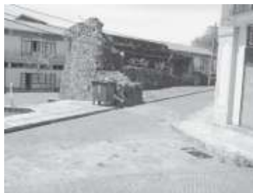
Figura 5. Restos del baluarte de La Mano del Tigre vistos desde el este. En primer plano se observa un trazado en piedra sobre la calle que indica el recorrido original de la muralla antes de su demolición.
