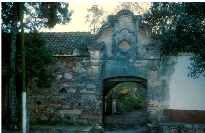
Figura 16. Ingreso al zaguán de las viviendas colectivas de Santa Catalina.
