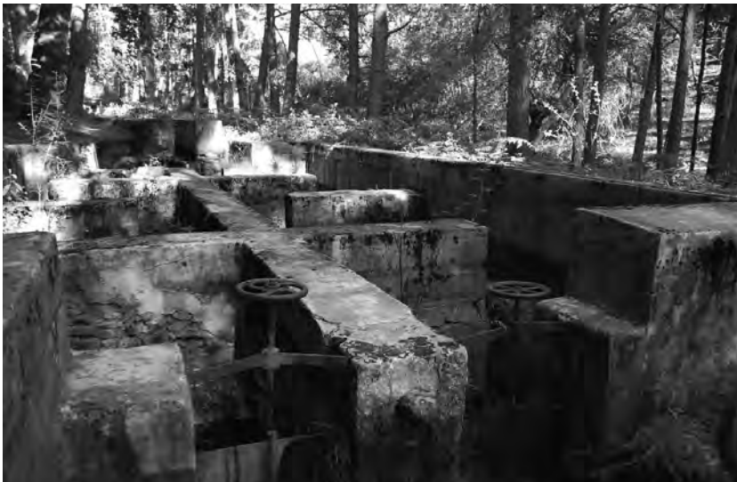
El azud del acueducto en el pinar de La Acebeda.
