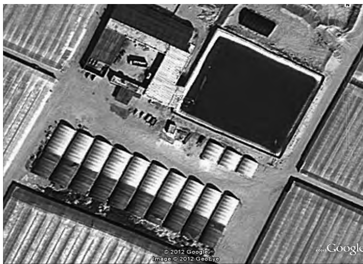
Figura nº 7 Detalle de la zona de fertirrigación de una explotación. Fuente: Google Earth.
