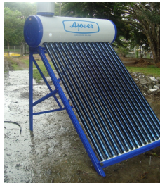
Figura 6. Colector solar de tubos de vacío
