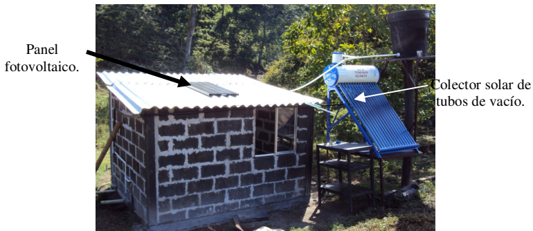
Figura 17. Montaje general de módulo de vivienda ecosostenible. (Los detalles del sistema fotovoltaico, la construcción de ladrillos y todo el proyecto Kyrios, se publicará en próxima edición).
