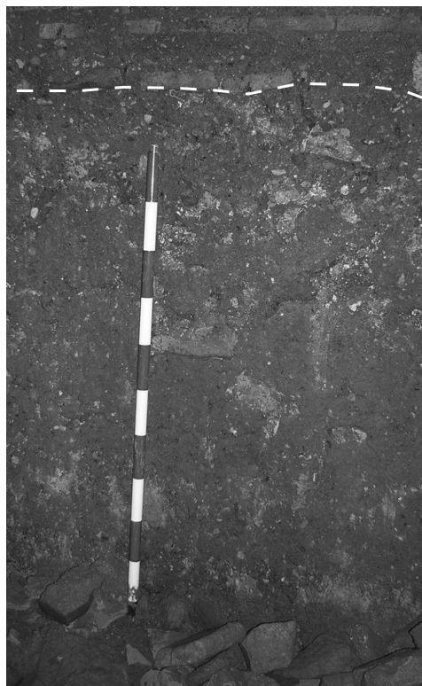
Fig. 13. Detalle del interior de la Cripta II: pared enlucida y punto de arranque de la bóveda; en la parte inferior de la fotografía puede advertirse restos del relleno de escombros
