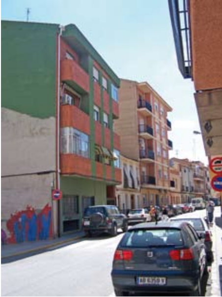
50. Vista de la C/ del Campo desde el cruce de la C/ San Luis donde se muestra la utilización de distintos materiales y colores a capricho del promotor y/o técnico.
