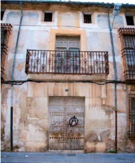
18. Fachada de la vivienda sita en la C/ Nueva nº 8 donde se puede ver el alfiz que enmarca el acceso. Elemento decorativo típicamente gótico.
