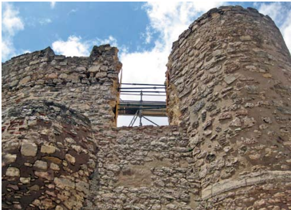
Fig.22. Reconstrucción de la puerta cegada, ubicada cercana a la torre del homenaje.
