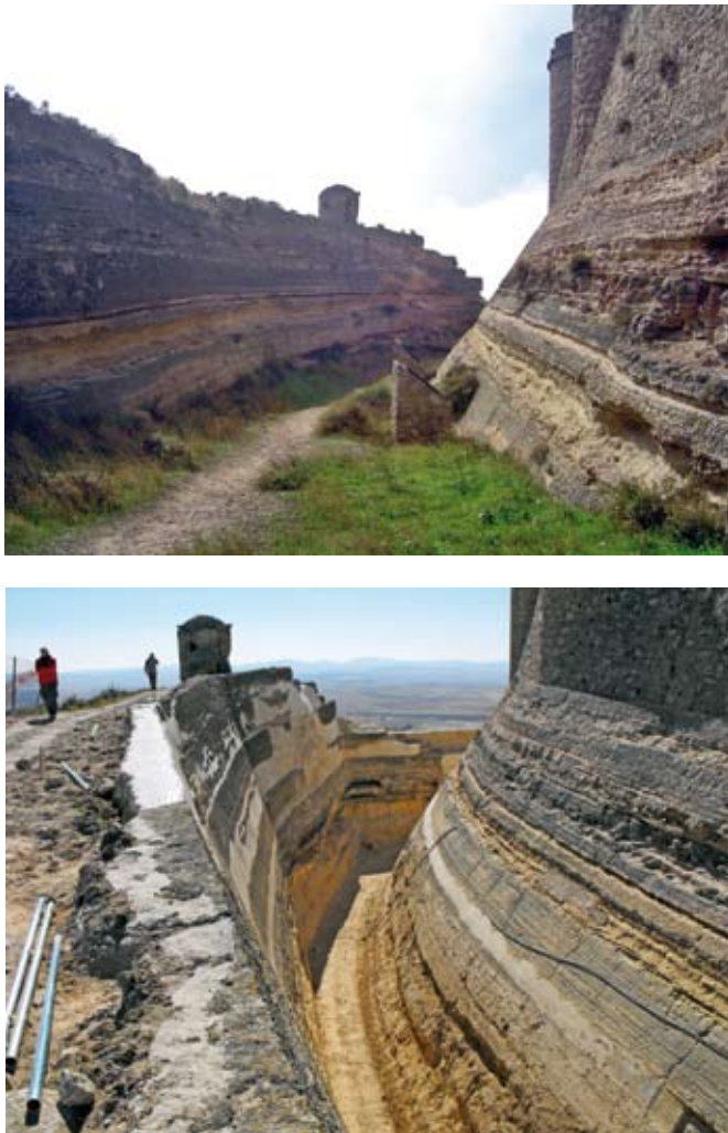
Fig. 1 y 2. Vista antes y después del proceso de limpieza y vaciado del foso.
