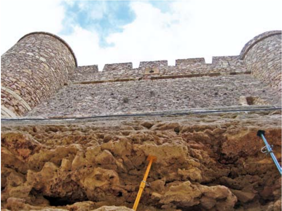
Fig. 3. Vista del lienzo desde la base del foso, donde se aprecian las cárcavas.
