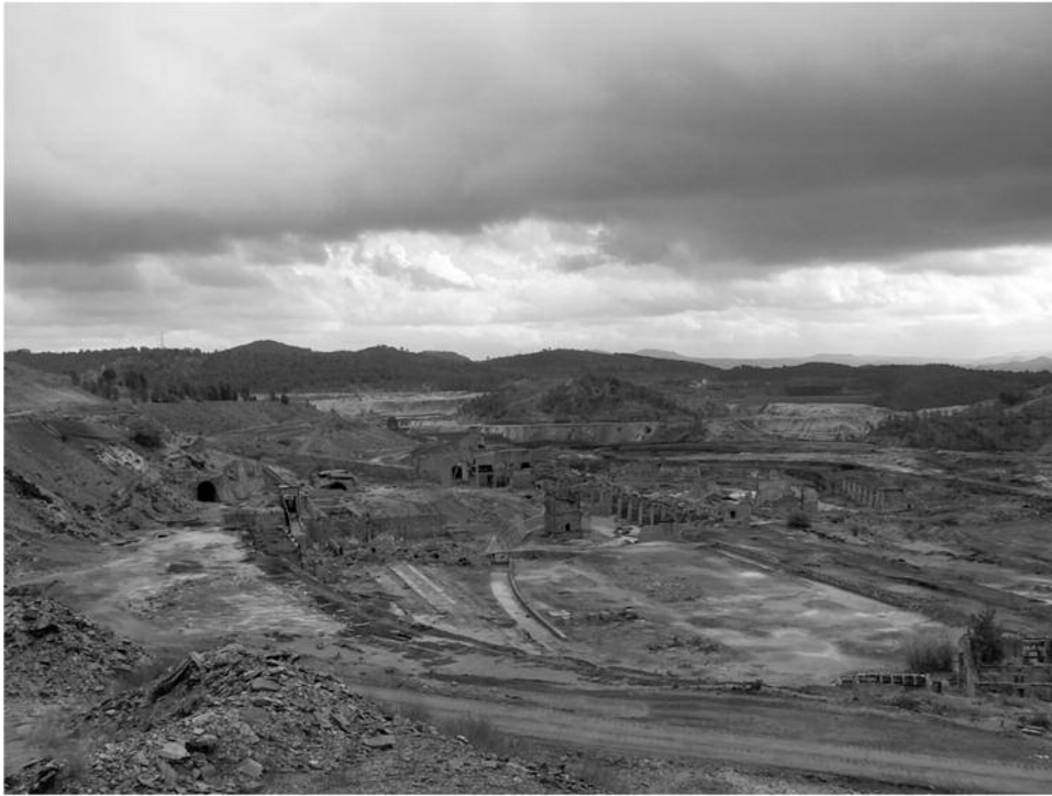
Figura 7. Fundición de Piritas, Minas de Riotinto.
