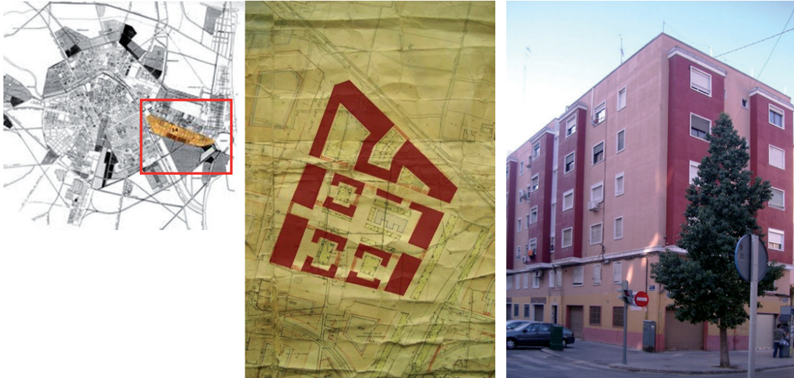
Figuras 28 y 29. Zona de edificación abierta entre las calles de Bilbao y Alboraya (solución aprobada) y vista actual de uno de los bloques lineales de la calle Río Escalona.
