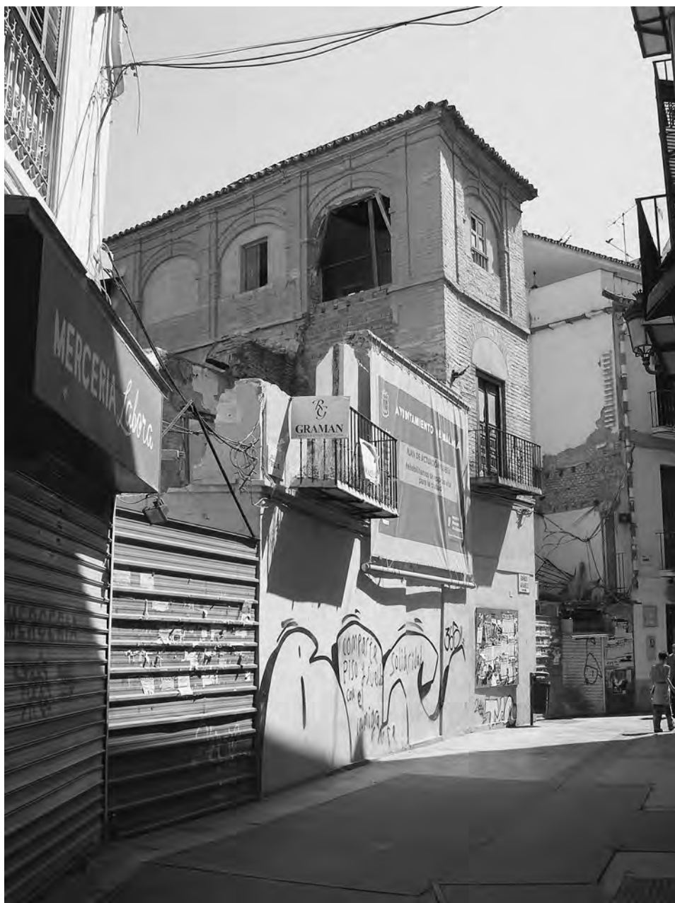
FIG. 2. Málaga, mismo inmueble en 2006. La situación de deterioro, tanto de la construcción como de su entorno, se mantuvo durante décadas y hasta fecha reciente. Se puede apreciar la torre mudéjar totalmente en ruinas y la vivienda anexa desaparecida. Foto: Belén Calderón.
