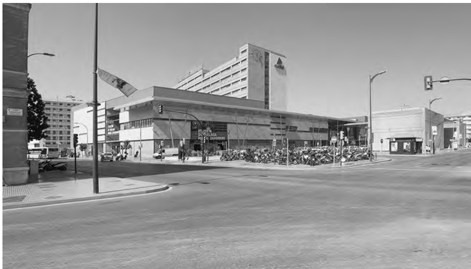
FIG. 7. Málaga, nueva Estación de Ferrocarril construida para la llegada del AVE, 2011. La antigua estructura decimonónica de hierro y cristal flanqueada por dos módulos paralelos ha desaparecido. Foto: José David Ruiz Barba.
