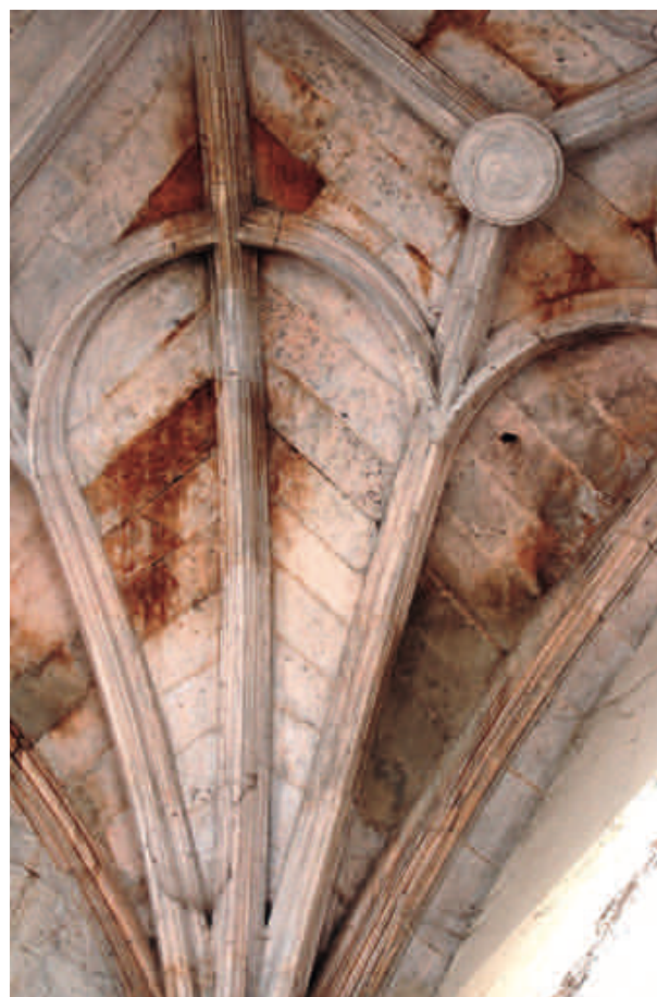
Figura 15. Bóveda del coro de Vadocondes, donde se aprecia la perfección con la que han sido tallados los plementos del cierre.
