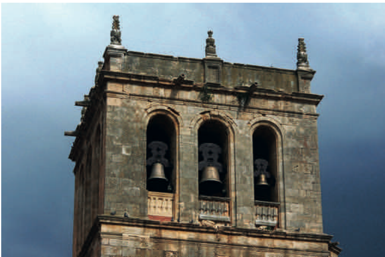
Figura 4. Remate de la torre de Vadocondes, con tres huecos por frente con balaustrada y pináculos de coronación, tomando la imagen de residencia urbana a imagen del Palacio de Monterrey de Salamanca.
