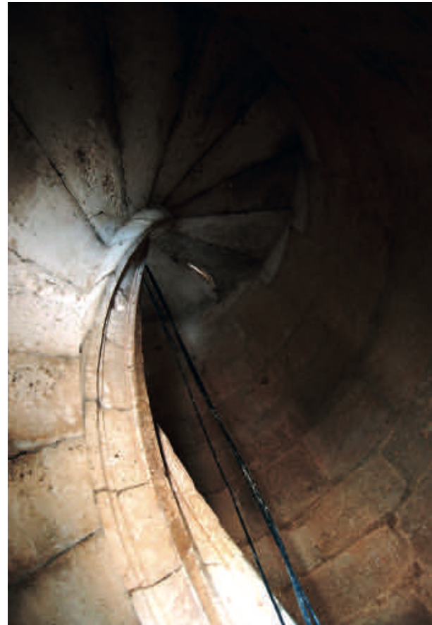
Figura 3. Escalera de la iglesia de la Asunción de N ra S a en Vadocondes, construída como caracol de Mallorca.
