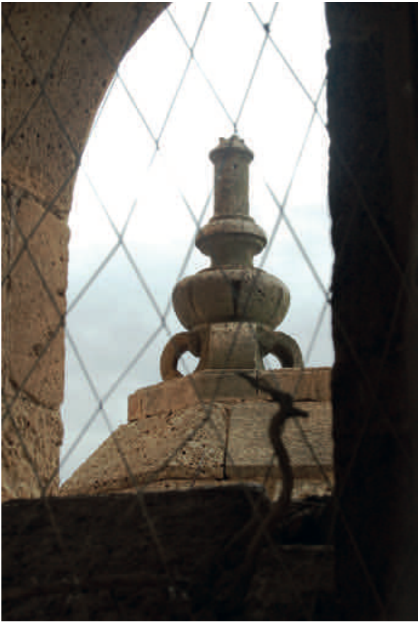
Figura 11. Detalle de coronación de la escalera de caracol de Vadocondes. El jarrón es muy similar a los que flanquean la portada de la Universidad de Santa Catalina en el Burgo de Osma.
