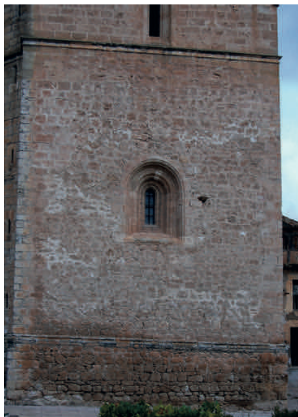
Figura 6. Parte baja de la torre de Santa Ana en Peñaranda de Duero, obra construida en mampostería por Bartolomé de Pierredonda hacia 1540.
