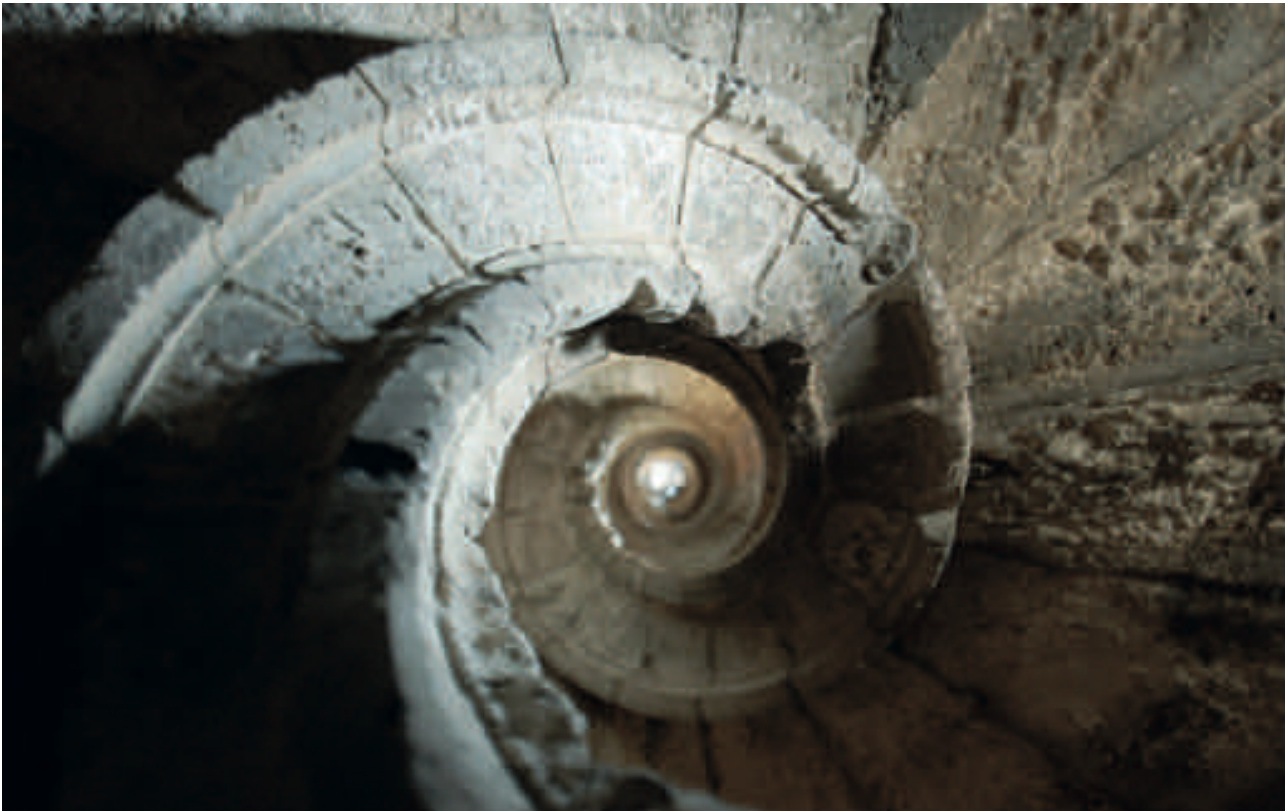
Figura 12. Óculo de la escalera de Vadocondes, construida en caracol de Mallorca.
