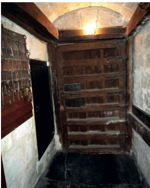
Figura 8. Entrada a la torre de Peñaranda, con puerta de ocho goznes apuntalada por largueros horizontales sobre un segundo marco de fábrica. A la izquierda parte la escalera que lleva al campanario.
