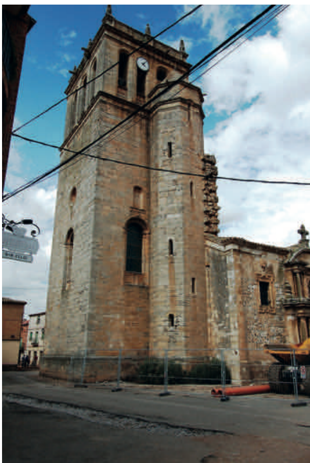
Figura 13. Vista desde el ángulo suroeste de la torre de Vadocondes. En el campanario, los huecos se desplazan para crear simetría desde la arista del edificio, como en el Palacio de Monterrey en Salamanca.
