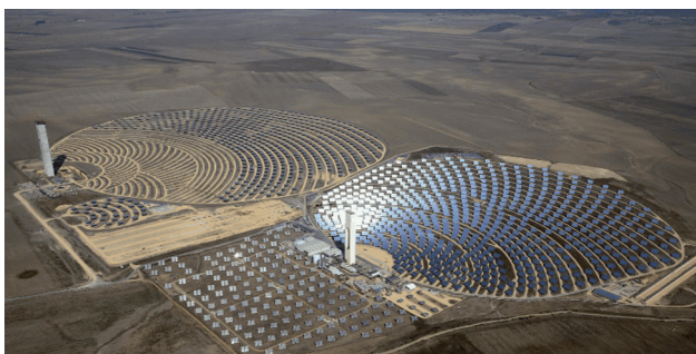
Figura 9. Captación de energía solar térmica de torre central con heliostatos.
