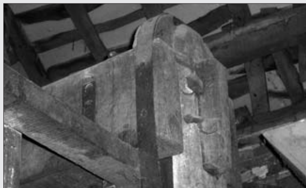
DETALLE DE LA PARTE D'ARRIBA DE LES VÍRGENES, ONDE SE PUEN APRECIAR LOS TORNOS Y LES CINCHES DE FIERRO QUE LES ASUXETABEN. FOTO FELICIANO SUÁREZ
