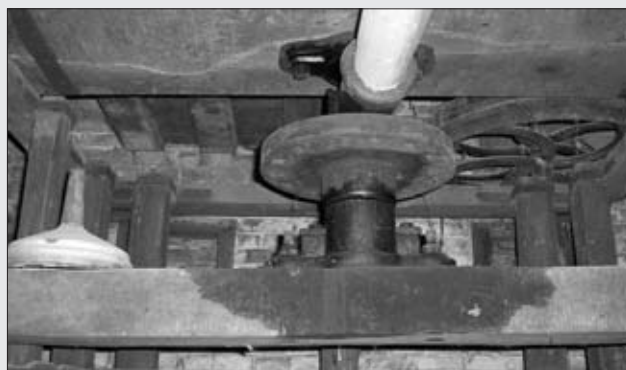
EL FUSU, COLA PÉRTIGA. A LA IZQUIERDA, L'EMBUDU DE TRASEGAR LA SIDRA Y A LA DERECHA LOS RABILES DE LA MÁQUINA DE MAYAR. FOTO FELICIANO SUÁREZ
