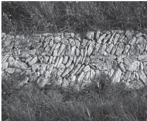
Mur de pedra seca
