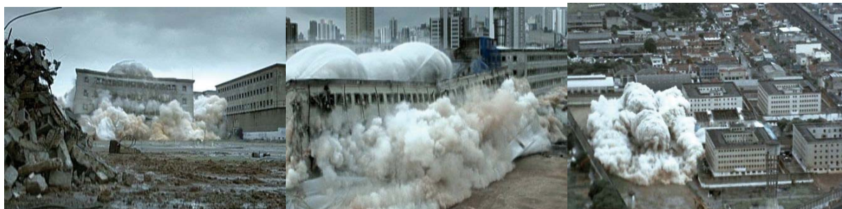
Figura 8. Imágenes registradas en vídeo de la explosión del complejo.
