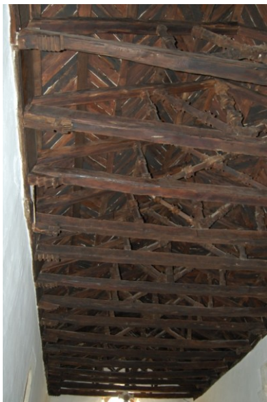
FIG. 5. MARACALAGONIS, CHIESA DI SANTA MARIA D'ITRIA, COPERTURA LIGNEA, PARTICOLARE
