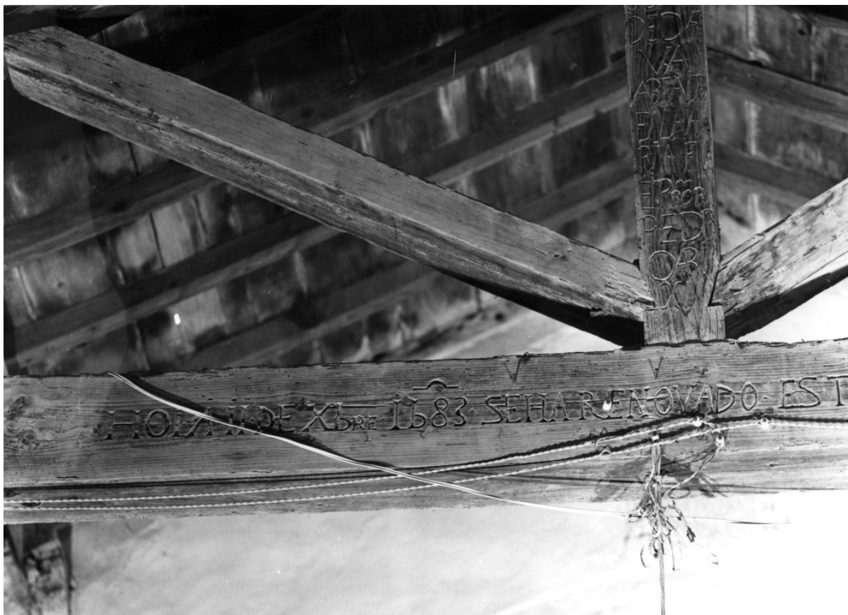
FIG. 16. SANLURI, CHIESA DI SAN LORENZO, INTERNO, CAPRIATE LIGNEE, IMMAGINE DEL MARZO 1989 (ARCHIVIO FOTOGRAFICO SOPRINTENDENZA BAPPSAE PER LE PROVINCE DI CAGLIARI E ORISTANO, SANLURI/CHIESA DI SAN LORENZO, N.35212)
