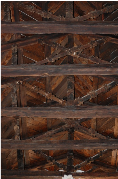
FIG. 3. MARACALAGONIS, CHIESA DI SANTA MARIA D'ITRIA, COPERTURA LIGNEA
