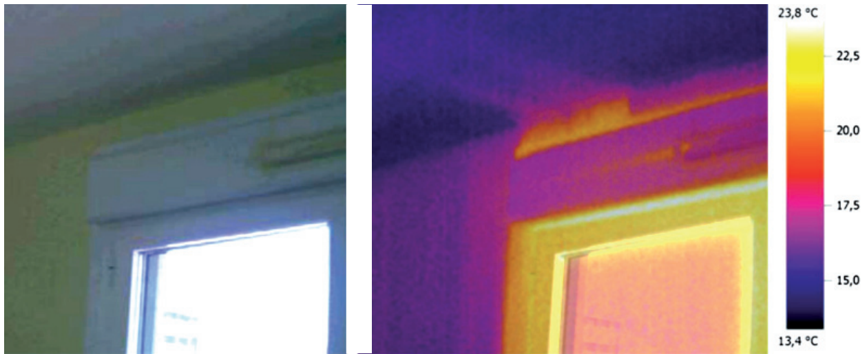
5 Ejemplo de uso de la termografía infrarroja para localizar las infiltraciones
