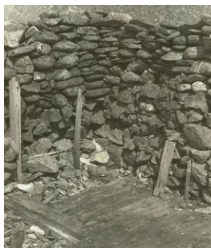
FIGURA 3 CASA-HABITACIÓN, DETALLE INTERIOR
