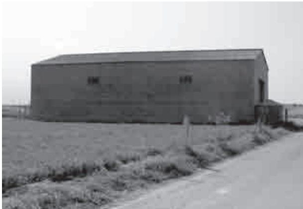
Nau de tàpia de formigó a Barbens.
