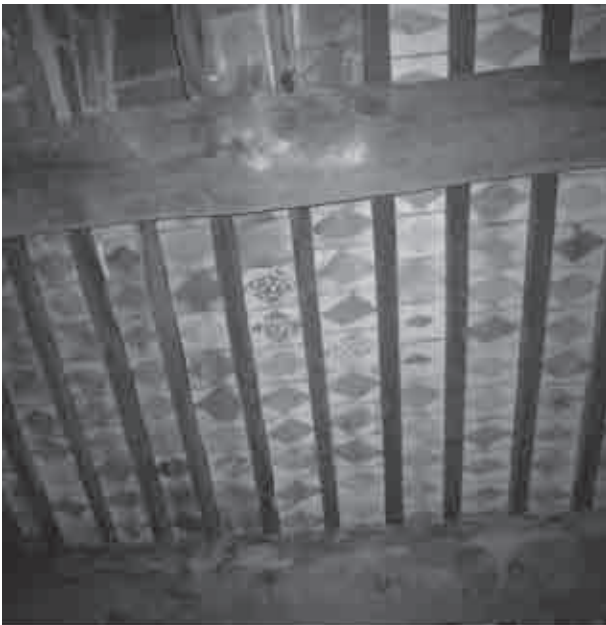
Vista de les rajoles i bigues de sota la teulada de Cal Jan de Miralcamp.
