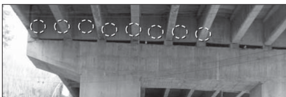
Figura 6. Detalle de la posición donde se instalarían los aisladores.
