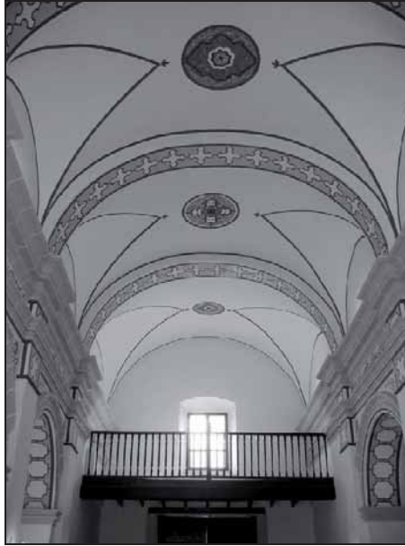
3. José González de Coniedo, interior de la ermita.
