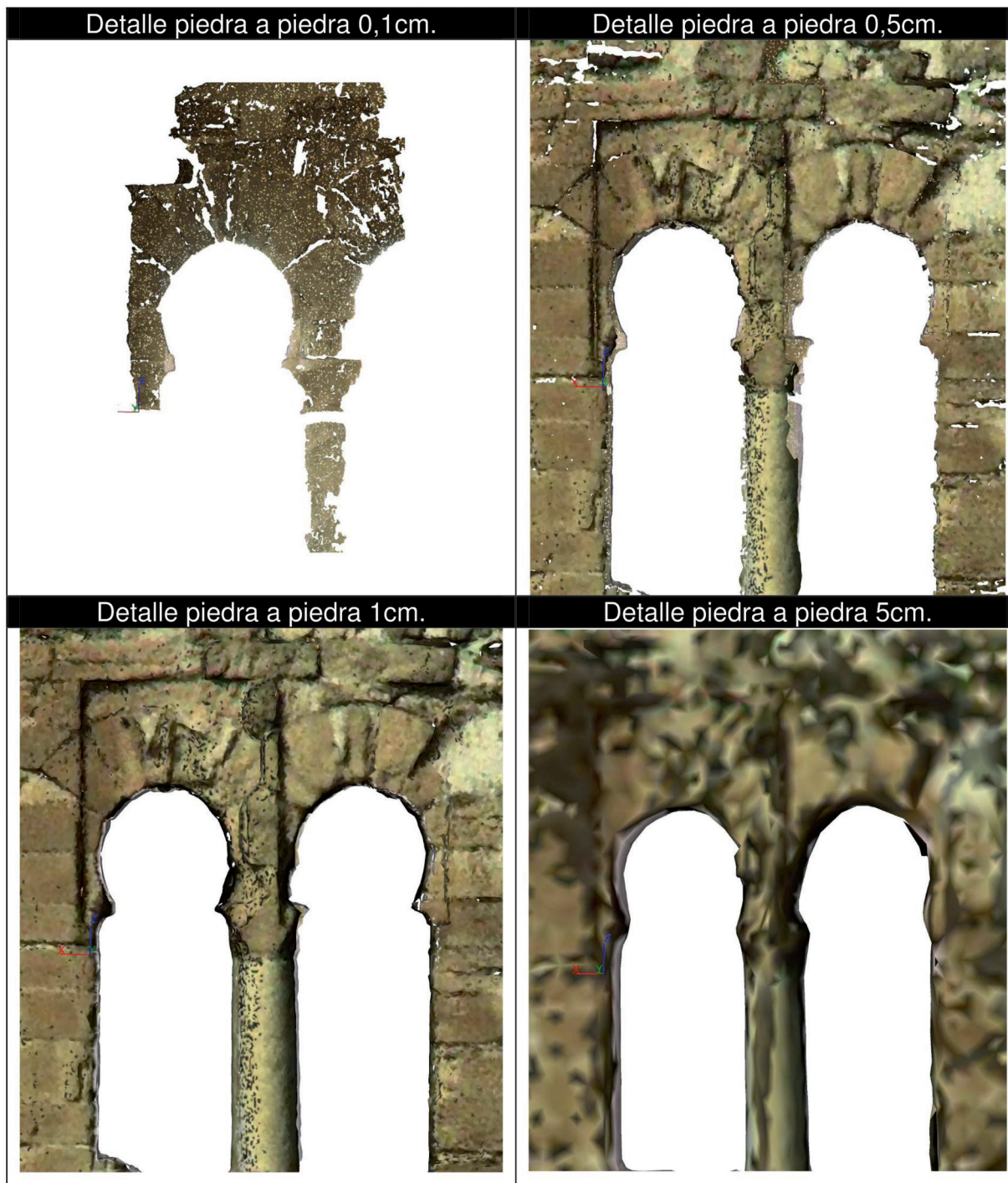
Fig. 24: Representación de la ventana de doble arco a distintas resoluciones.
