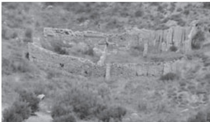
Restos de lo que podría ser el almacén, donde se aprecian contrafuertes, muros de carga y vigas caídas.
