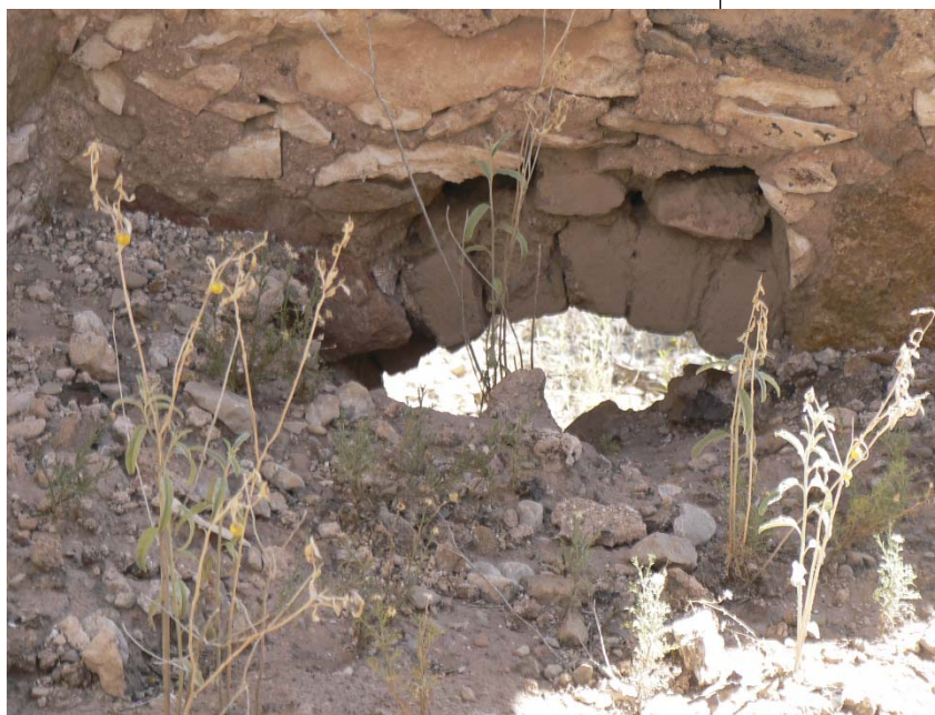
Figura 6. Detalle del dovelado en una puerta de trabajo. Fotografía del autor (2011).
