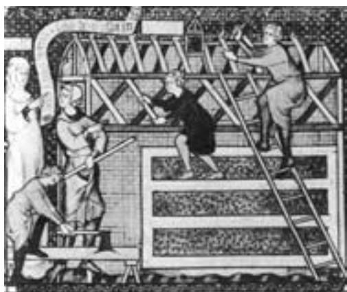
Maestro carpintero supervisando el trabajo de construcción de la cubierta (Siglo XIV, vista de Saint-Denis) Gimpel, (1993)
