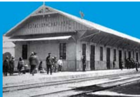
FOTO DE LA ESTACIÓN DEL FERROCARRIL DEL NORTE
