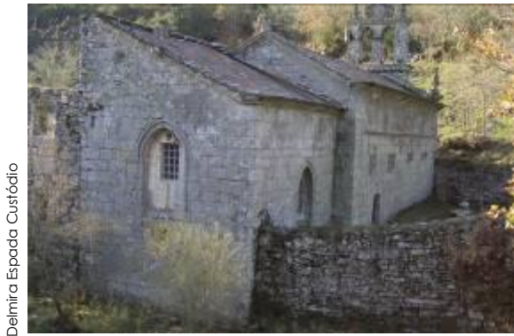
Fachada Norte vista de noroeste
