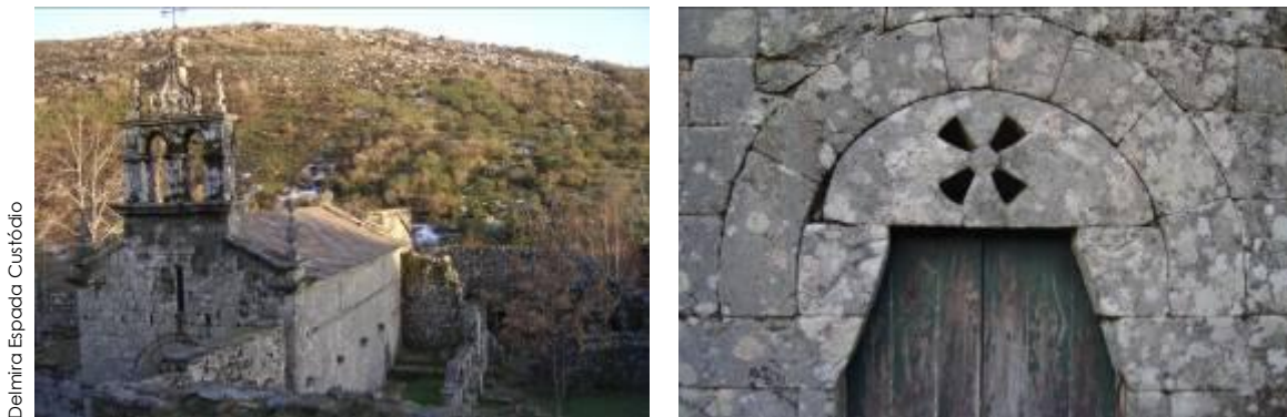
Fachada Sul Porta Sul onde é visível o que sobrou do desenho do lintel.
