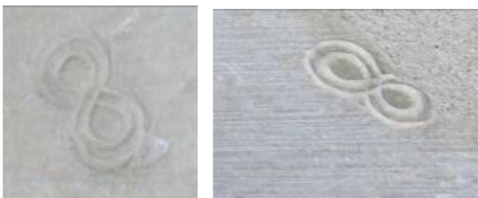
Marcas de canteiro gravadas numa das paredes do dormitório do Mosteiro de Alcobaça.
