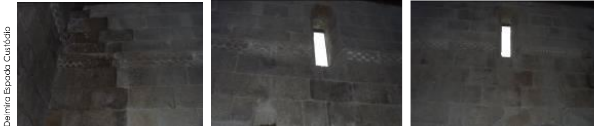
Variação do friso ao longo da fachada Norte.
