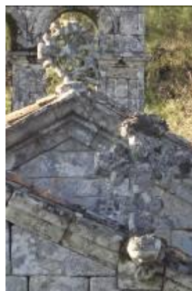
Coroamento das fachadas posteriores da nave e da cabeceira.
