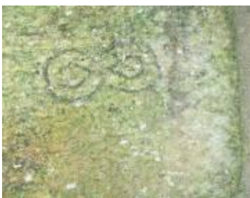
Marca de canteiro gravada na parede norte da cabeceira.
