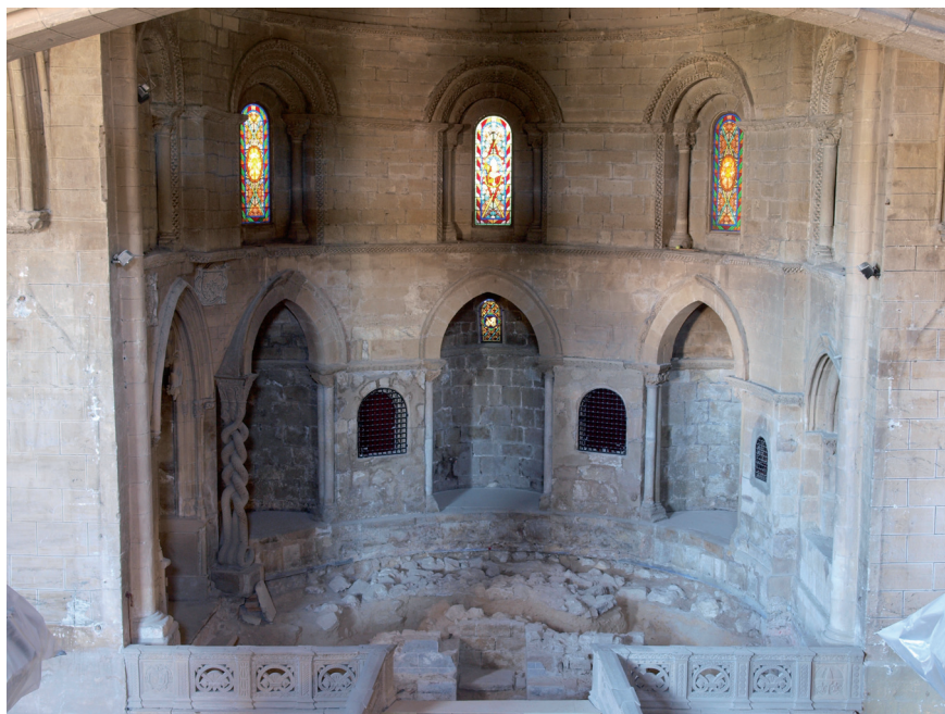
▪ Fig. 4. San Pedro de la Rúa. Interior del ábside central.
