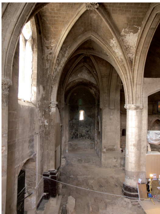
▪ Fig. 7. San Pedro de la Rúa. Nave septentrional, vista hacia el Este.
