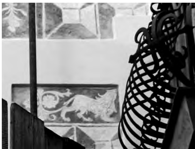
Fig. 6. Palermo. Palazzo Settimo, dettaglio della grottesca graffita al piano nobile.
