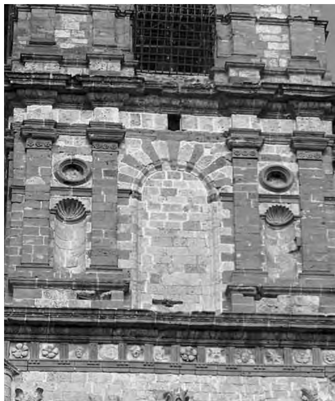
Fig. 6. Piazza Armerina. Cattedrale, particolare della parte superiore del campanile.
