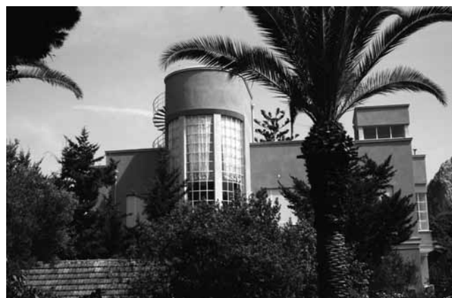
Fig. 5. Palermo. Villa Sorge a Mondello, prospetto su via Principe Umberto.
