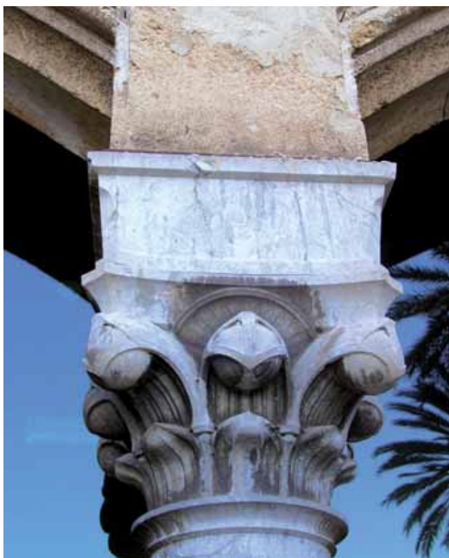
Palermo. Villa Igia, particolare del capitello del portico sul mare.
