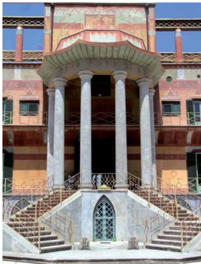
Palermo. Palazzina Cinese, facciata.
