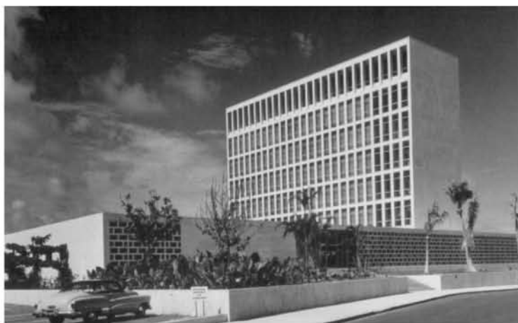
Embajada EE. UU. en La Habana, obra de Harrison & Abramovitz.
