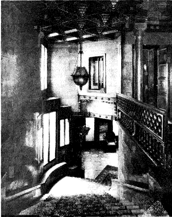
Escalera del vestíbulo hacia la planta noble
