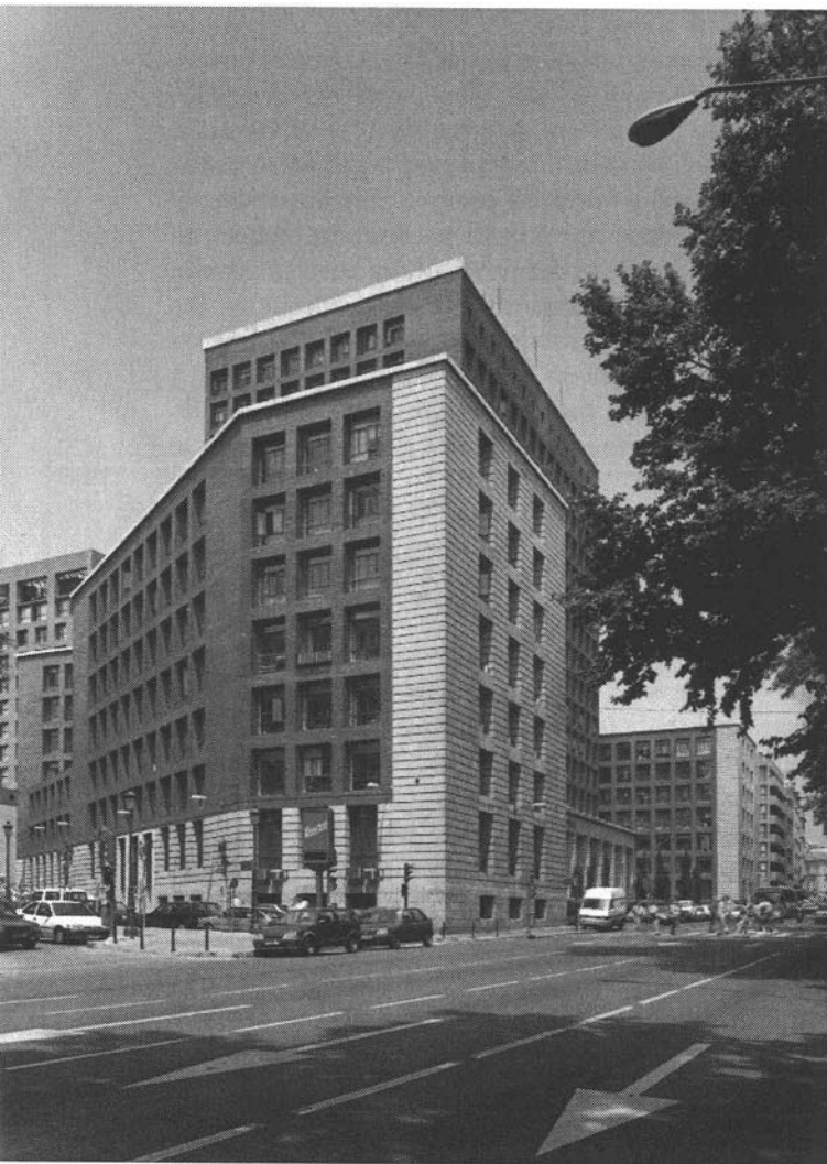
Edificio de la Delegación Nacional de Sindicatos. Vista desde la calle.
