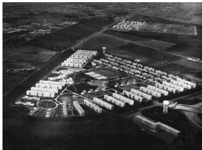
Figura 6. Unidad Vecinal nº 3 (1949). Vista aérea del conjunto. Fuente: Oficina Nacional de Planeamiento y Urbanismo (1958)
