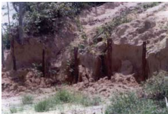
FIGURA 3. Instalação das estacas, fazenda Morro Verde, município de Castanhal. PA. Setembro de 2002.
