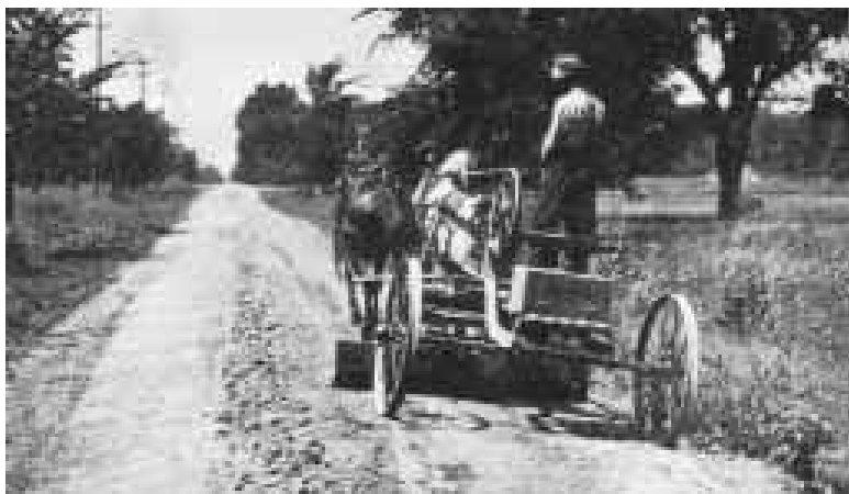
Niveladora tirada por caballos, usadas en la construcción de la Carretera Central
