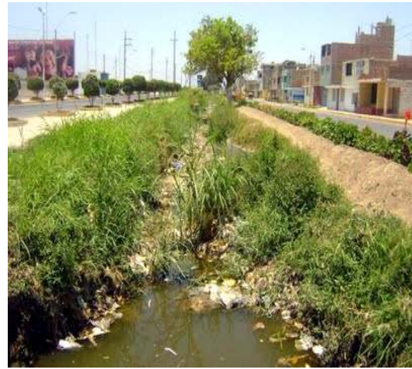
Figura 6. Acequia Yortuque, estación (E-10).
