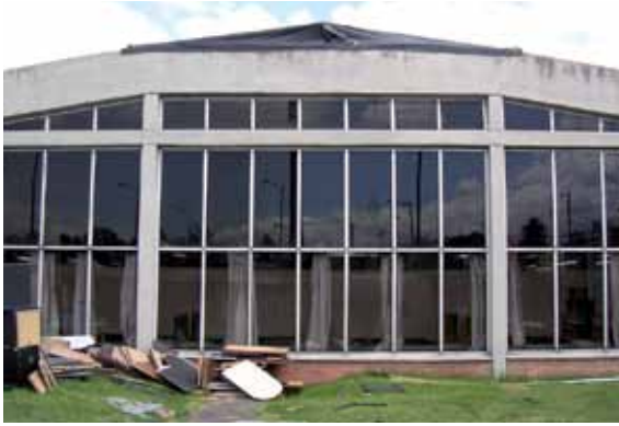
Figura 4. Estado anterior del edificio de la piscina. Fuente: Archivo de Arquitectos Asociados
