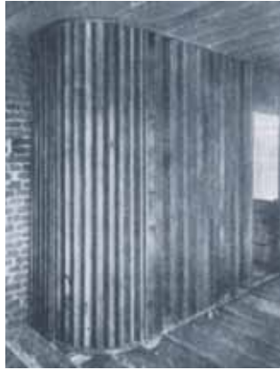
Figura 6. Obra de la casa 18 de Ludwig Hilberseimer. Se utilizan diferentes espesores en el sistema Feifel Zick-Zack, para los muros de carga, los tabiques divisorios y los entrepisos (1927)
