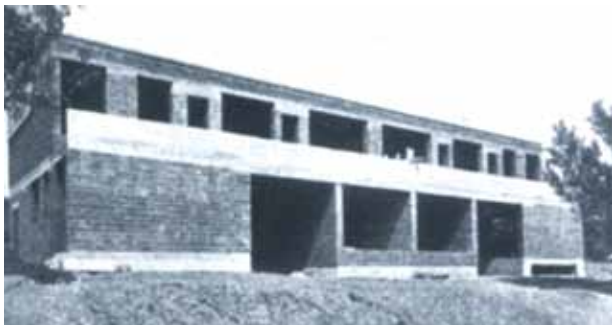
Figura 19. Obra de las casas 26 y 27, de Josef Frank. A pesar de ser un bloque estructural, el arquitecto logró vanos amplios para permitir una adecuada relación exterior-interior de las viviendas (1927)
