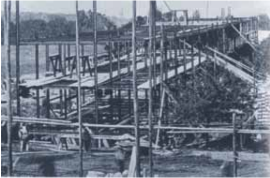
Figura 14. Obra de la casa 1-4, de Mies van der Rohe. Montaje del esqueleto metálico (1927)
