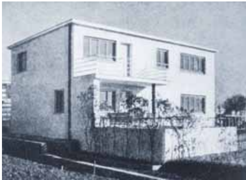
Figura 17. Exterior casa 11, de Adolf Schneck. Los bloques marcan la modulación de la vivienda y, por lo tanto, el orden y el tamaño de sus vanos (1927)
