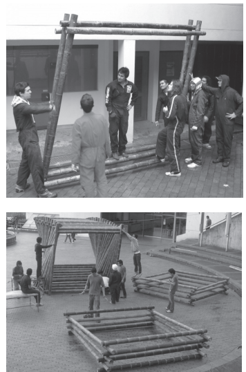
Figura 4. Construcción del pabellón en el campus de la Universidad.
